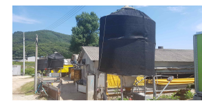
사료빈 차광막 설치
