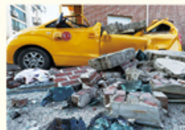
• 조계도 외벽 파손으로 인한 차량파손
