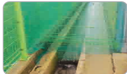
배수구 그물망 설치
