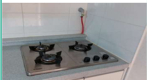
금속배관 및 퓨즈박스 설치
