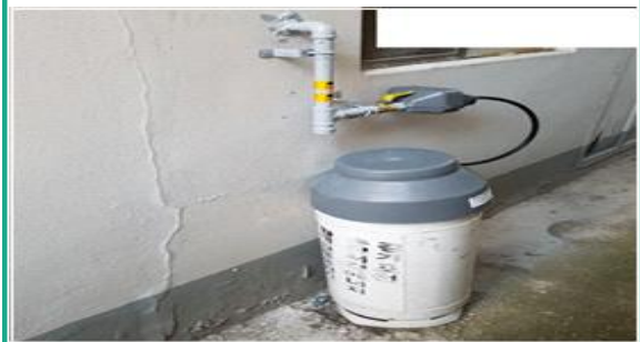
금속배관 및 용기차양 설치
