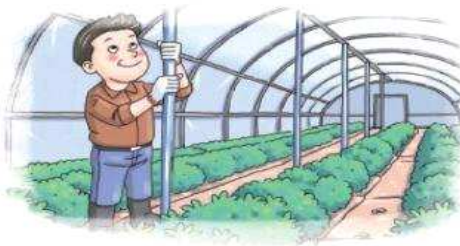
• 노후화된 시설 등은 보강지주 설치
