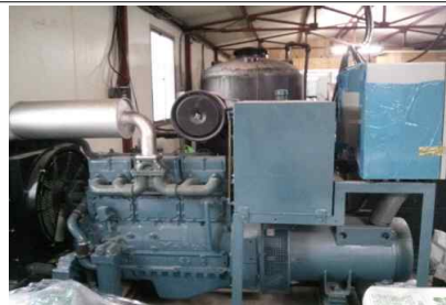
작업장 내부 자가 발전기 설치
