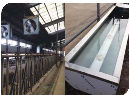
송풍기 온도조절 및 일반수조 사용
