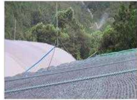
<축사 지붕 위로의 물 분사>
