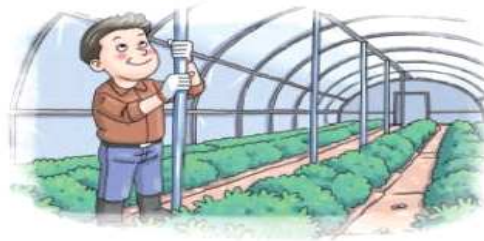
• 노후화된 시설 등은 보강지주 설치
