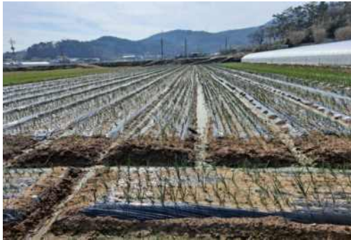
머릿골 배수로 설치
