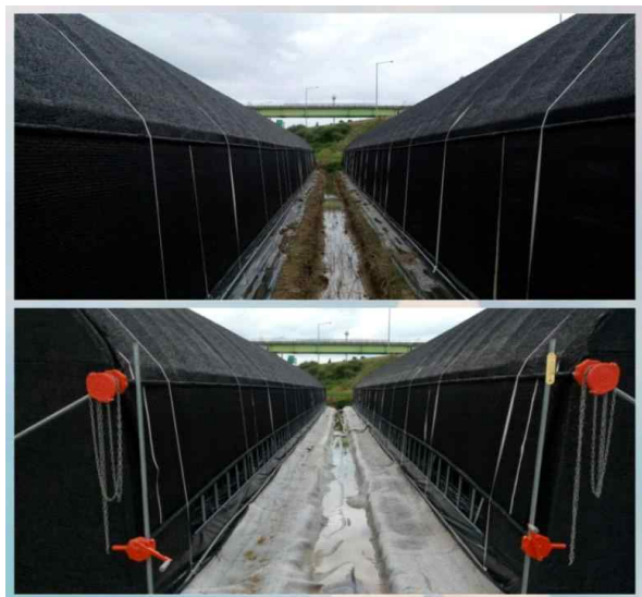
《시설 간 배수로 정비》
