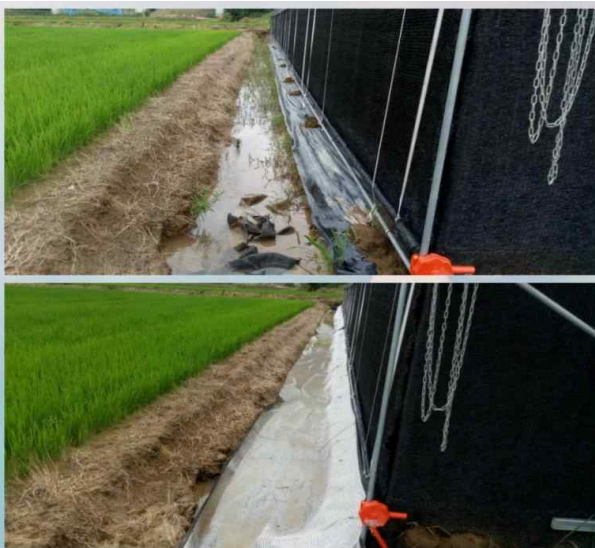
《시설 주변 배수로 정비》
