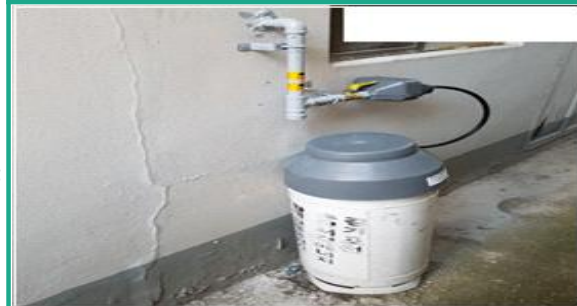
금속배관 및 용기차양 설치
