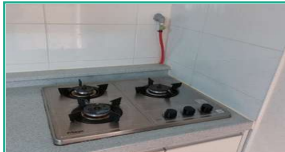
금속배관 및 퓨즈콕 설치
