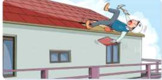
▶ 신축공사 : 3년간 32명 사망 단독주택 신축공사 현장에서 지붕 실리콘작업을 하다가 미끄러지면서 추락하여 사망
