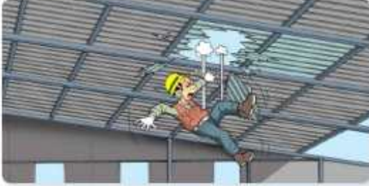
▶ 공장지붕 개보수 : 3년간 43명 사망 지붕강판 자재를 정리하고 지붕위에서 이동하다 채광창을 밟고 추락하여 사망
