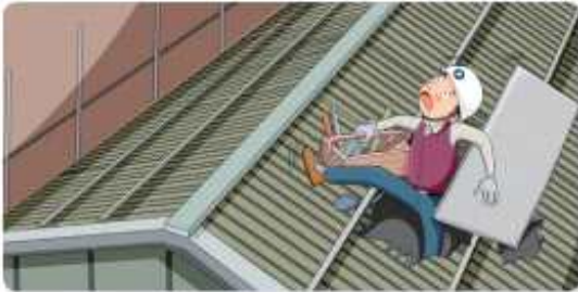
▶ 축사지붕 개보수 : 3년간 21명 사망 축사 지붕(슬레이트 등) 교체 작업 중 노후된 지붕을 밟고 추락하여 사망
