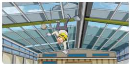
▶ 태양광 설치공사 : 3년간 11명 사망 지붕위 태양광 패널 설치를 위한 자재를 옮기다가 채광창 파손으로 추락하여 사망
