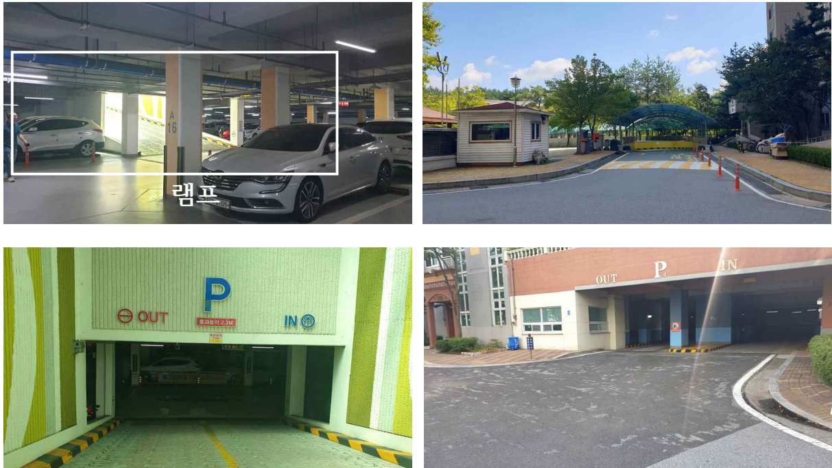
<그림 24> 램프 출구와 램프 입구모습
