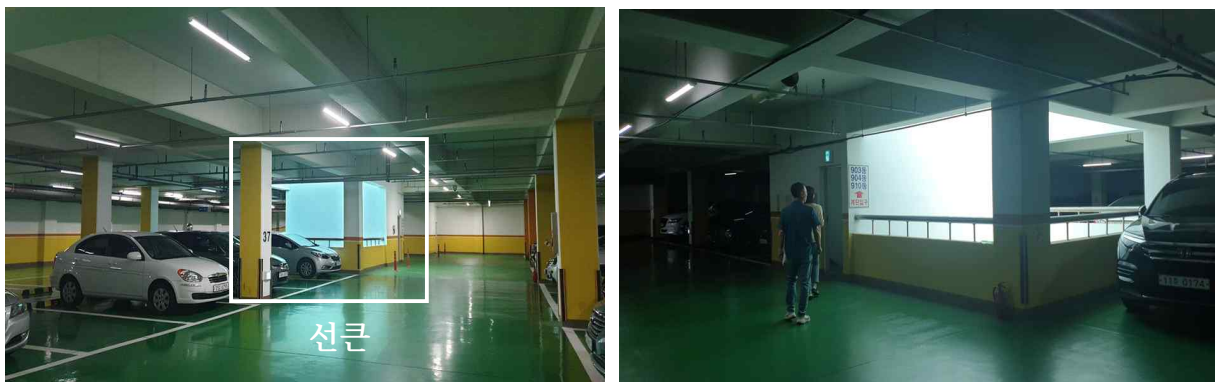
<그림 23> 선큰이 설치된 지하주차장
